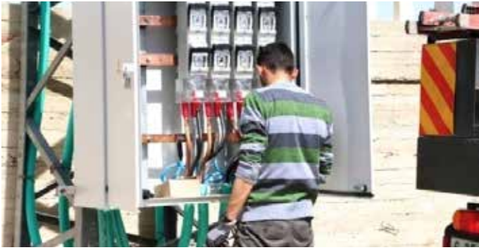
6. صيانة اللوحات الكهربائية العامة ومجمعات التوزيع .
